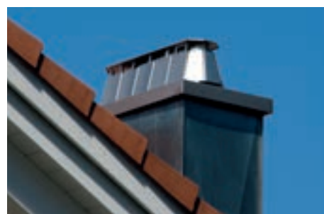
Une tôle de séparation placée entre les conduits empêche que la fumée s'échappant d'une cheminée puisse pénétrer dans une autre.
