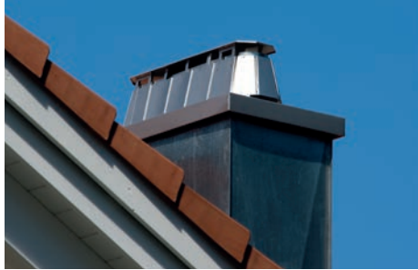
Zwischen den Kaminzügen verhindert ein Trennblech, dass der Rauch von einem in den anderen Kamin gelangen kann.
