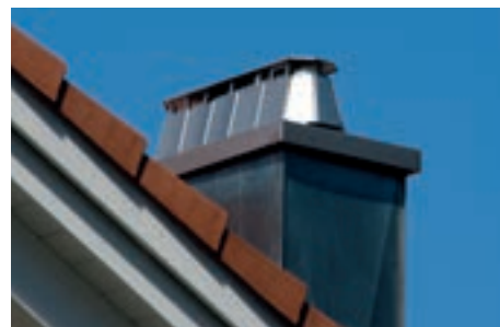
Zwischen den Kaminzügen verhindert ein Trennblech, dass der Rauch von einem in den anderen Kamin gelangen kann.
